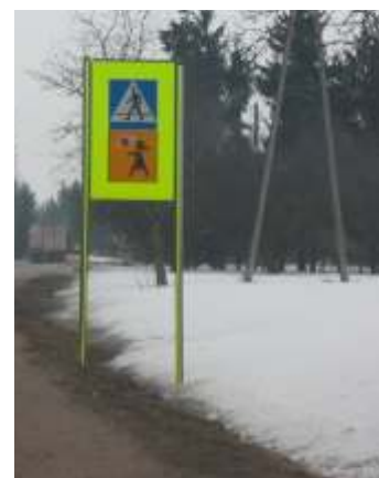
Słupki oklejone fluorem poprawiają widoczność konstrukcji
