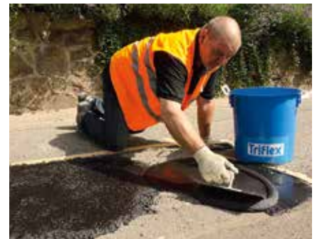
5 Rozprowadzić, a następnie wygładzić materiał za pomocą kielni.
