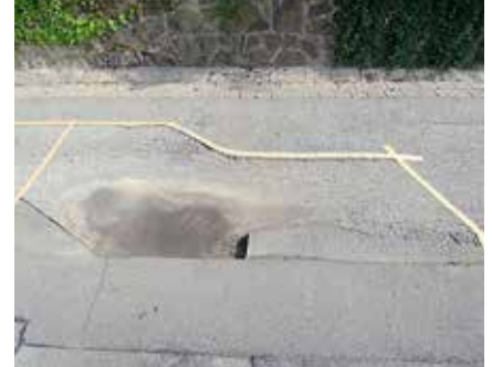
2 Ograniczyć taśmą samoprzylepną obszar wymagający renowacji.
