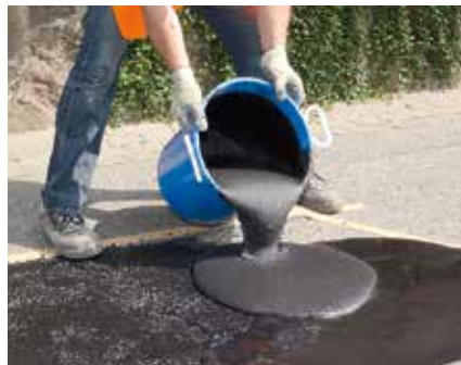
4 Nanieść wymieszany materiał na naprawiany obszar.
