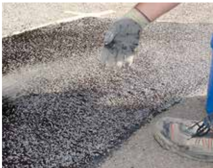
6 Obsypać świeży materiał grysem (uziarnienie 1–4 mm).
