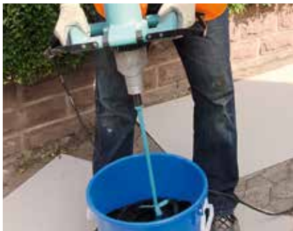
3 Przemieszać Triflex Asphalt Repro R oraz Triflex Asphalt Repro S przez ok. 1–2 minuty.
